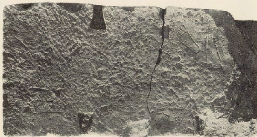
Dalles de la corniche du 1er pylône montrant les graffitis des pèlerins et les queues d'aronde.
